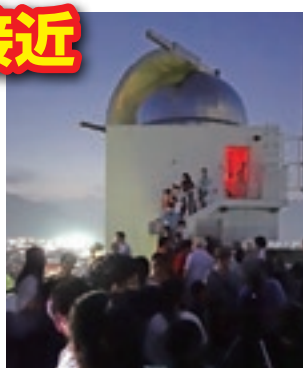
屋上 天体観測室
