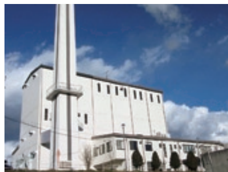
外壁修繕後の東部クリーンセンター
