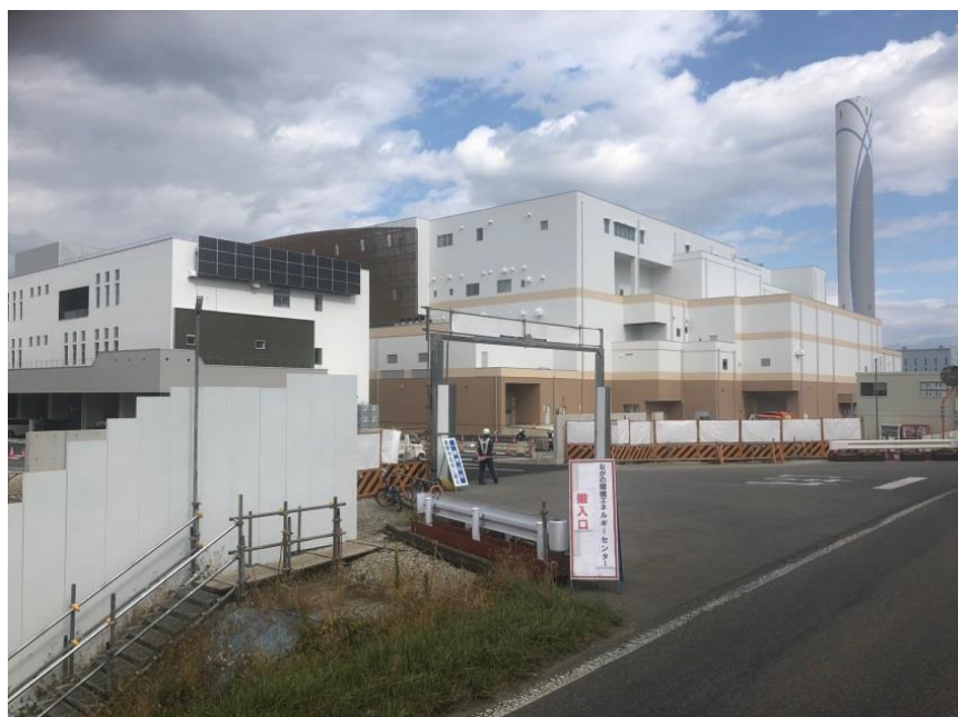
ながの環境エネルギーセンター(千曲川堤防側 搬入口)
