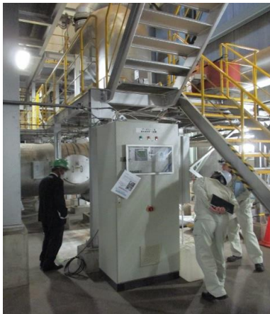
写真① アメサコントロール・キャビネット外観
