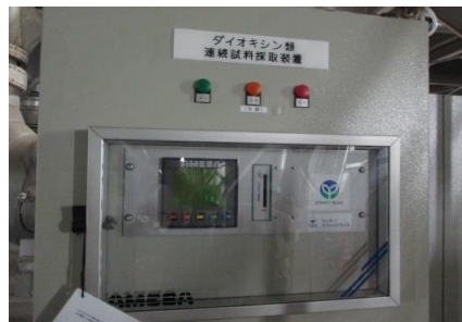
写真② アメサコントロール・キャビネット拡大
