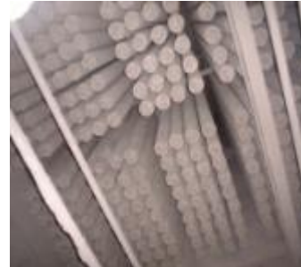
写真 2b ろ過式集じん器内部
