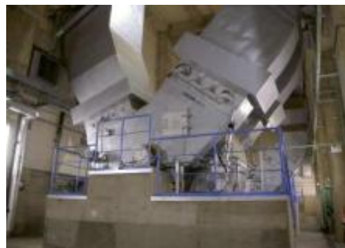
写真 4 誘引送風機外観
