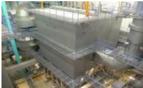
写真 2a ろ過式集じん器外観
