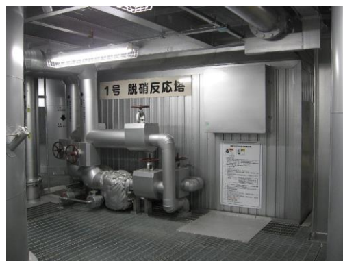
写真 3 脱硝触媒塔外観
