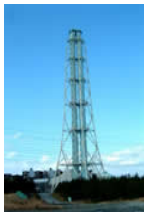
写真 4-3b 鉄塔支持集合煙突
