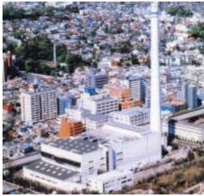
写真 4-3c コンクリート外筒煙突
