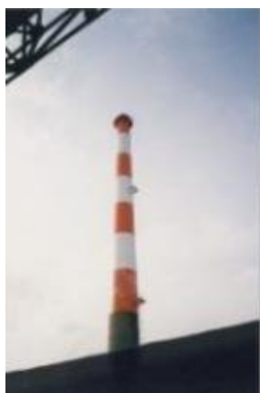
写真 4-3a コンクリート製煙突
