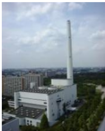
写真 4-1 東京 23 区光が丘清掃工場 (昭和 58 年竣工)
