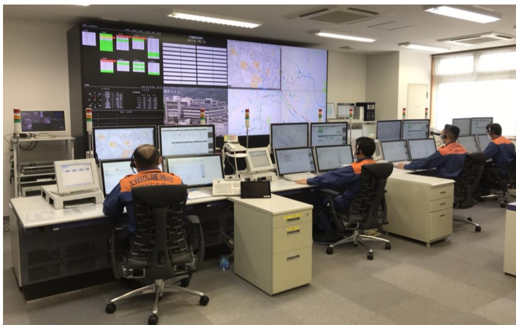
警防課通信指令室 (平成27年3月24日 高機能消防指令装置導入)
