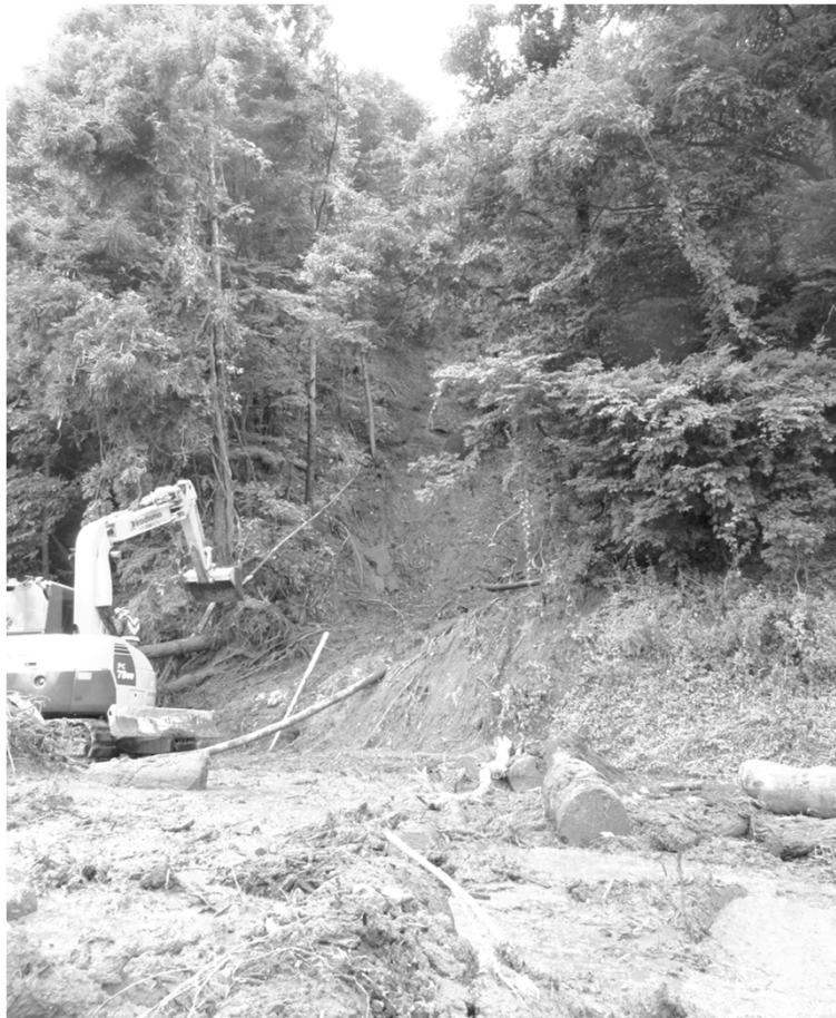
夏の豪雨により発生した土砂崩れ
